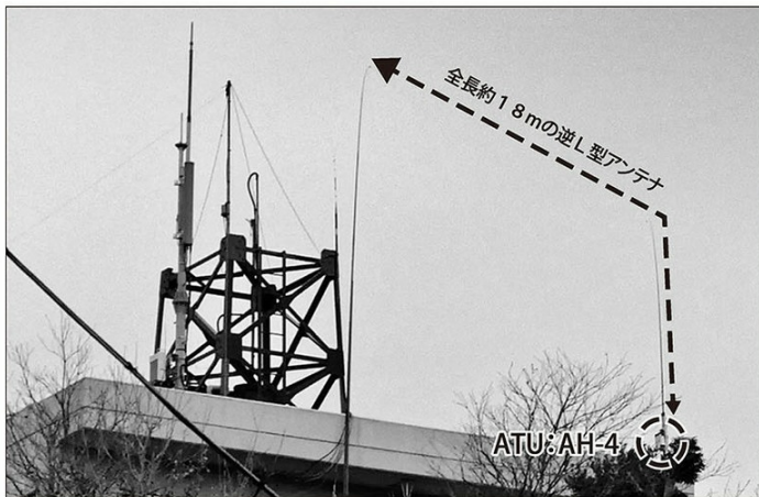
↑写真7-A/マンション屋上をぜいたくに使って設置したアンテナ。水平部分両端支柱には「あゆ釣り用」のグラフファイバー竿を約12mの間隔で立てた、全長約18mの逆L型アンテナ。
