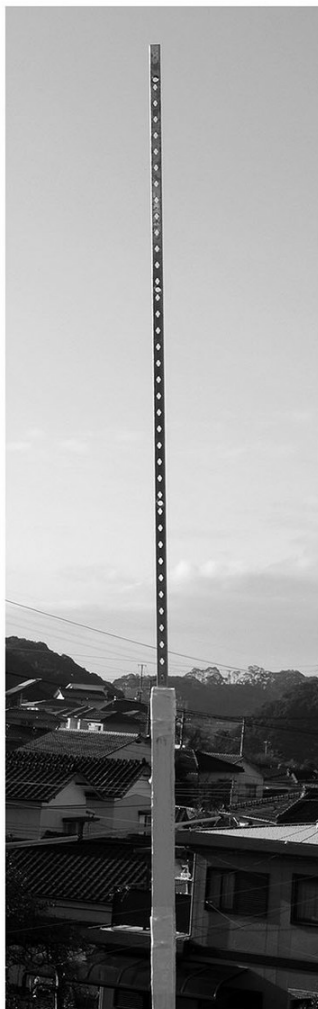
↑ステンレス板。後から付けたアンテナ先端のステンレス板。長さは85cm。1ランク上の長さのものもあったので、風のことを考慮のうえ、地域によってはそれを試してみてもいいかもしれない。いずれにせよ、このアンテナは予想以上に重くなっている所以需要だ。
