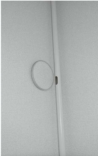
↑上側の貫通孔もあけた。エアコンのダクトを通す壁の貫通孔付近に配置することができた。
