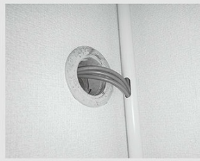
↑ダクト穴からケーブルを室内に引き込んでいる部分。
