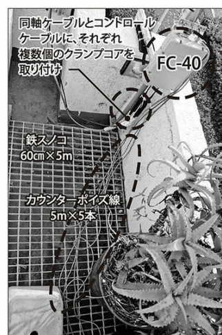
↑写真6-B/カウンターボイズ線はベランダ内の60cm×6mほどのがっちりした鉄のスノコ上に5m長を5本はわせている。
