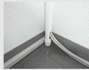
↑床近くの縦穴から、ケーブルを外に出している部分。
